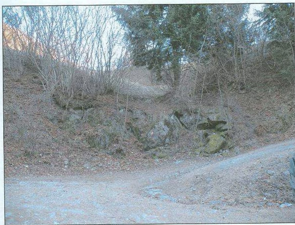
FOTOGRAFIA 3: corso d'acqua n° 205 del quale si propone l'aggiunta, presso l'attraversamento delle strade posto poco a monte della confluenza nel n° 46
